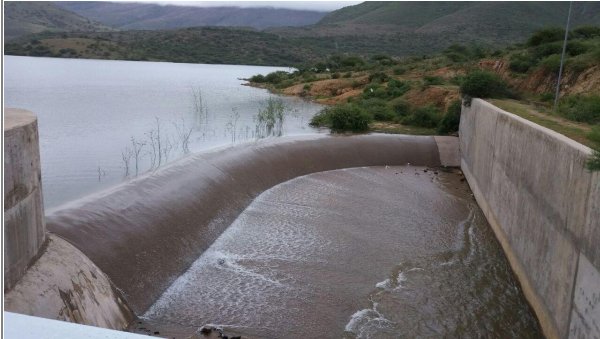
Vertedero de excedencias (SEDEGIA-2020)
